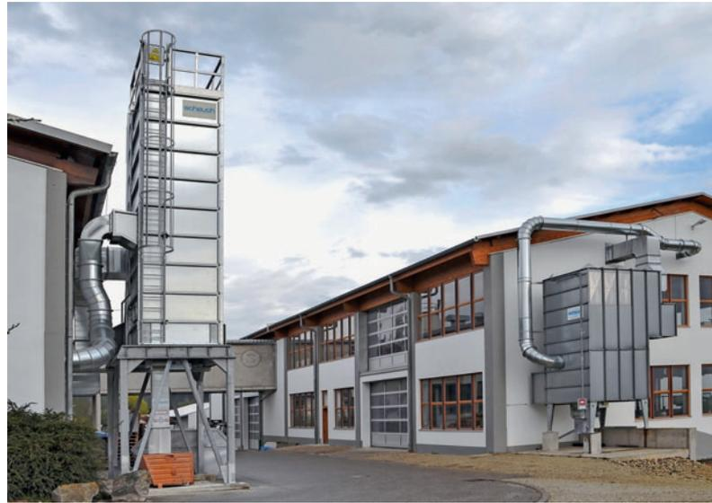
Links: die Filteranlage für den Mineralwerkstoffstaub. Sie reinigt mit Druckluft ab. Rechts: der Filter für die Säge und die Kantenanleimmaschine
