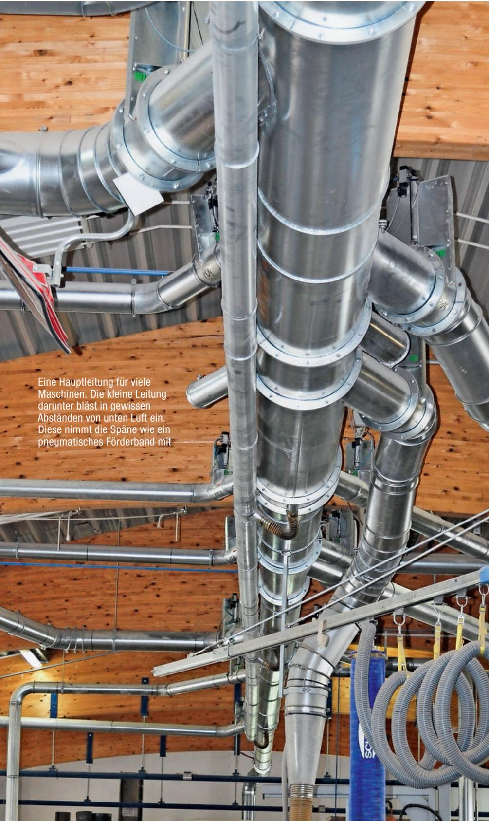
Eine Hauptleitung für viele Maschinen. Die kleine Leitung darunter bläst in gewissen Abständen von unten Luft ein. Diese nimmt die Späne wie ein pneumatisches Förderband mit
