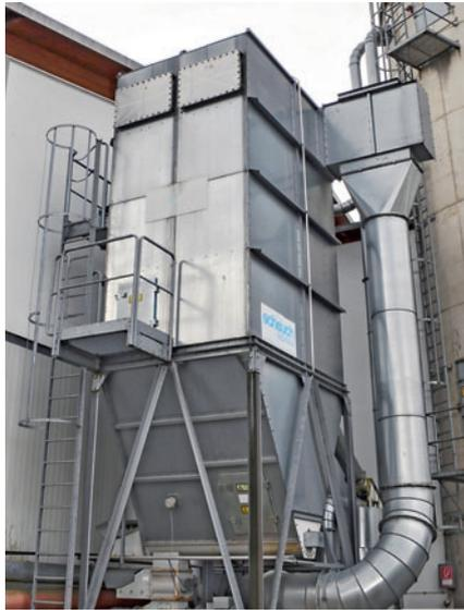
Die Filteranlage am Sepas-Plus-Strang mit Rüttelabreinigung, rechts dahinter das Silo
